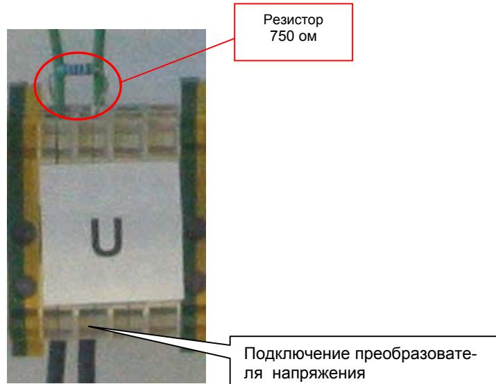
Рис. 5-1 Подключение клемм преобразователя напряжения
